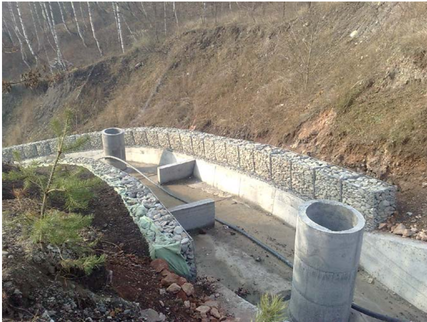
Fig. 2. Canal de preluare si dirijare a apelor – vedere de Ansamblu
