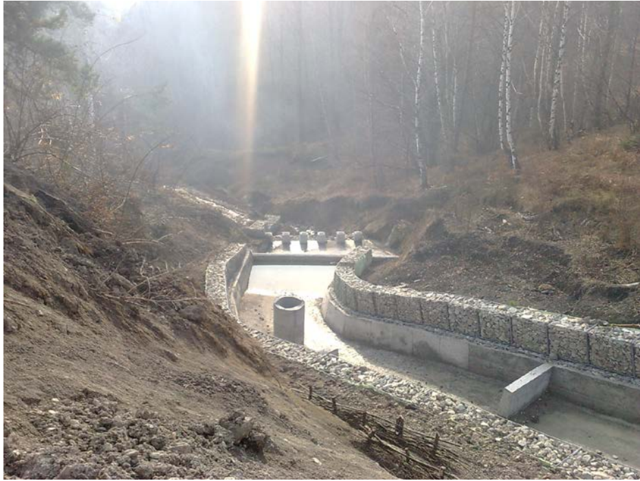
Fig. 4. Deversorul cu stalpii din beton pentru disiparea energiei apei la capatul din aval
